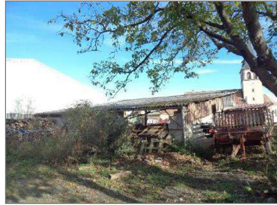
Exploitation en centre ancien ayant subi des dégâts suite à l'incendie
