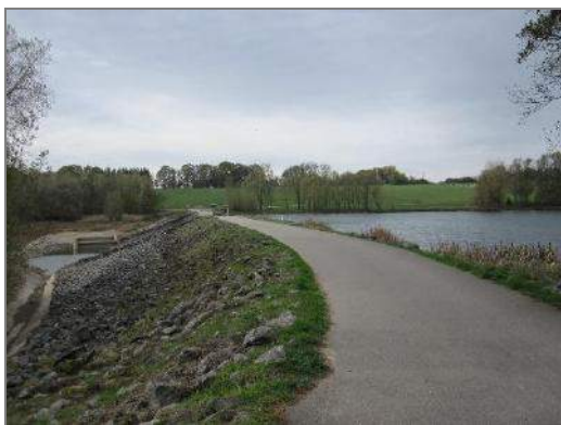
Le barrage de Michelbach
