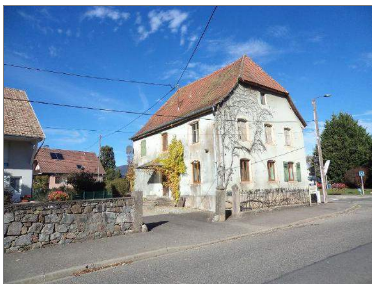
Maison d'habitation (repérée par la base Mérimée - n°2 rue Principale) qui formait une unité avec la grange sur la gauche mais qui en a été détachée. Située à l'angle de la Grand Rue et de la route de Thann, cette belle demeure a conservé ses atouts patrimoniaux : encadrements de fenêtres en grès, toiture à petite croupe, pieds droits de portail, chasses roues.
