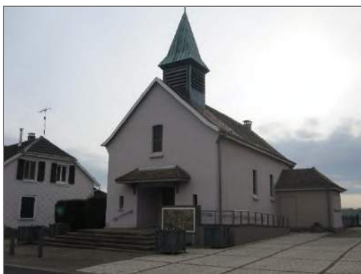
Revêtement de sol – Eglise – Rue Principale
